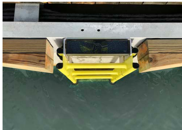
Support de fixation sur le ponton Vue de face 1:10
